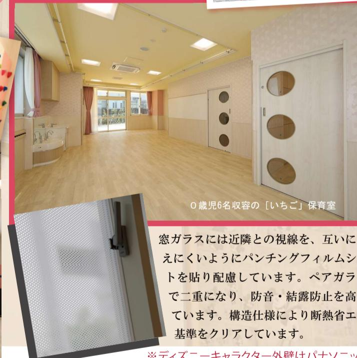
窓ガラスには近隣との視線を、互いに見えにくくするためパンチングフィルムシートを貼り配慮しています。ペアガラスで二重になり、防音・結露防止を高めています。構造仕様により断熱省エネ基準をクリアしています。
