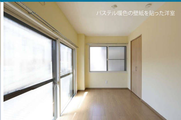
▲ 窓サッシはカバー工法によって、更に二重にペアガラス入りで設置。外部の騒音を遮断し、冬の結露防止にもなります。
