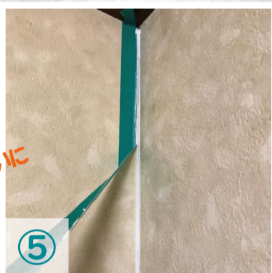
⑤ コーキング剤が乾いたら、マスキングテープを剥がす。
