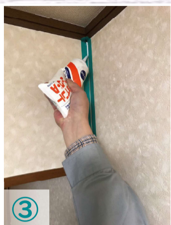
③ マスキングテープを貼り、クロスの継ぎ目にコーキング剤を注入する。
