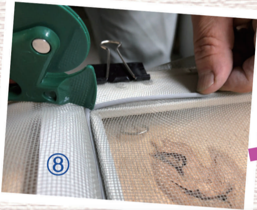
⑦ 新しい押さえゴムを網戸の溝にそって配置します。
