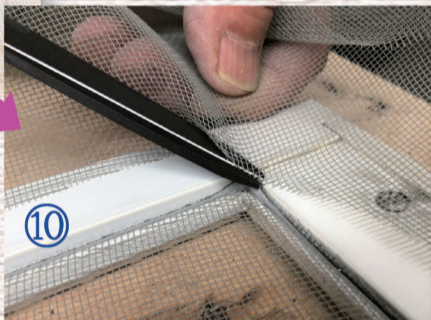
⑩ コーナー部分はカッター切断が難しいので、ハサミでていねいに網を切っていきます。
