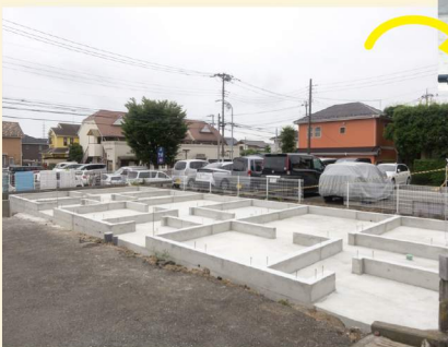
コンクリート打設が完成したところ
