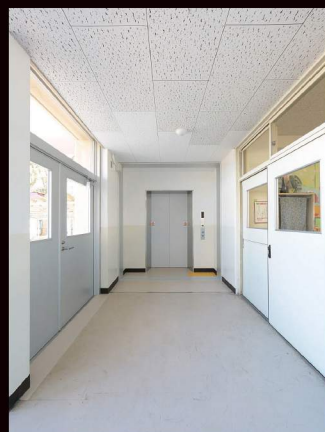
エレベーターの増設
