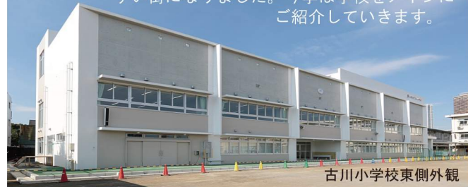
古川小学校東側外観
